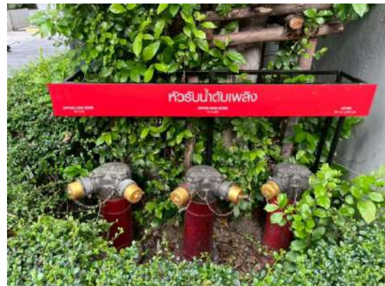
รูปที่ 2-26 ติดตั้งหัวรับน้ำดับเพลิง ของส่วนสำนักงาน และส่วนโรงแรม ทางทิศตะวันตกของโครงการ
