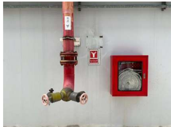
รูปที่ 2-26 ติดตั้งหัวรับน้ำดับเพลิง ของส่วนสำนักงาน และส่วนโรงแรม ทางทิศตะวันตกของโครงการ
