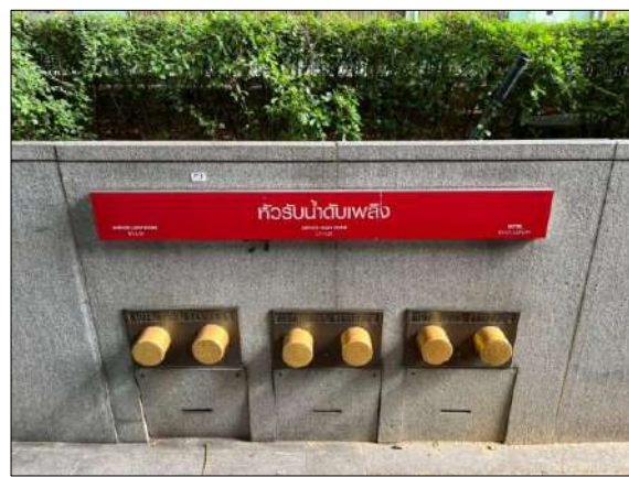
รูปที่ 1-9 หัวรับน้ำดับเพลิง ส่วนสำนักงาน และส่วนของโรงแรม
