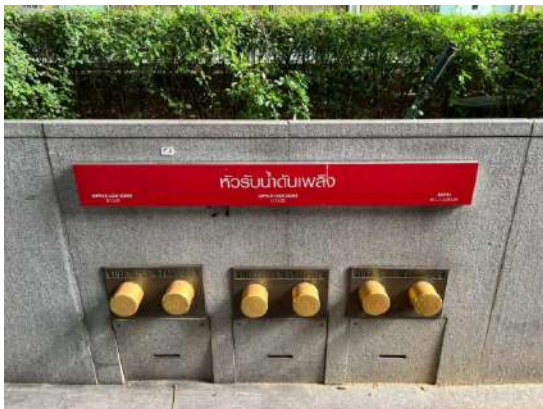
รูปที่ 2-27 ติดตั้งหัวรับน้ำดับเพลิง ของส่วนสำนักงาน และส่วนโรงแรม ทางทิศเหนือของโครงการ
